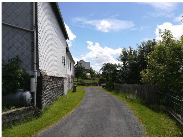
Abbildung 251: Geschotterte Ringstraße ohne Bürgersteige im Ortsteil Stangenrod
