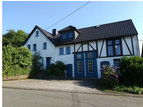
Abbildung 118: Erfolgte Umnutzung in der Straße Kirchweg im Ortsteil Unnau
