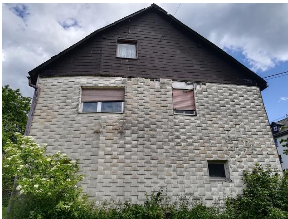
Abbildung 111: Von außen ersichtlicher Sanierungsbedarf in der Ringstraße im Ortsteil Stangenrod
