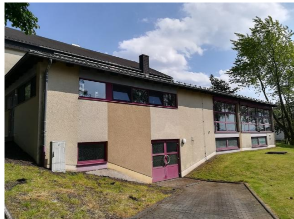
Abbildung 187: Mehrzweckhalle im Ortsteil Unnau Westseite
