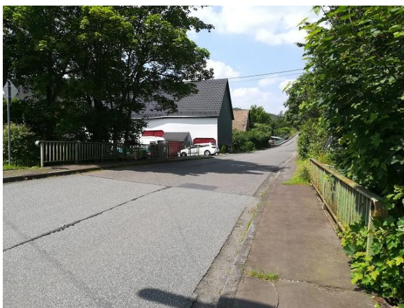
Abbildung 37: Brücke in der Hachenburger Straße / L 293 im Ortsteil Korb
