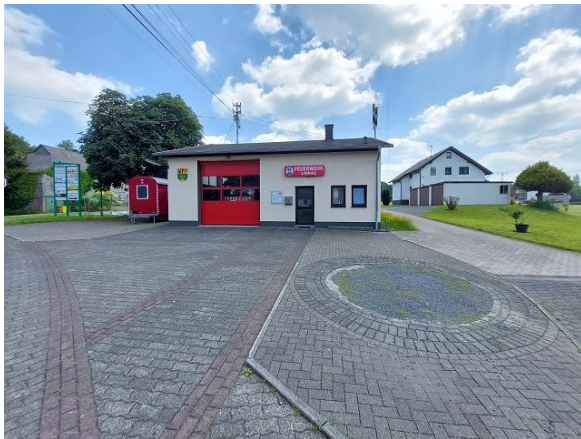
Abbildung 211: Feuerwehrgerätehaus im Ortsteil Korb
