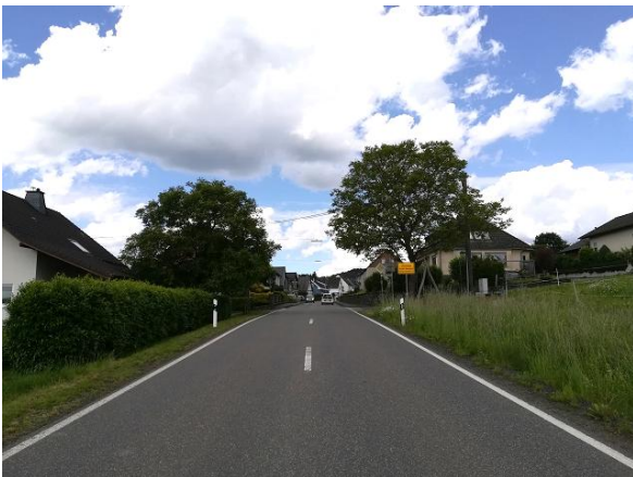
Abbildung 238: Südlicher Ortseingang an der Unnauer Straße / K 61 im Ortsteil Stangenrod
