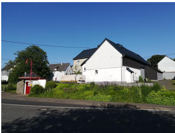
Abbildung 144: Großflächiges Beet bei der Platzgestaltung der Bushaltestelle auf der östlichen Straßenseite der Hauptstraße / L 293 im Ortsteil Unnau
