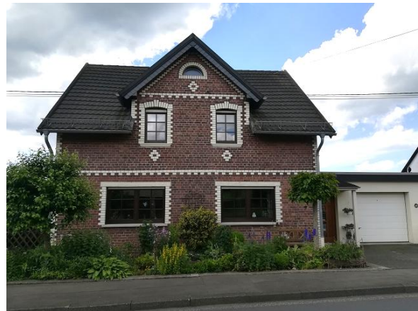
Abbildung 84: Sichtmauerwerk aus Ziegelstein im Ortsteil Stangenrod
