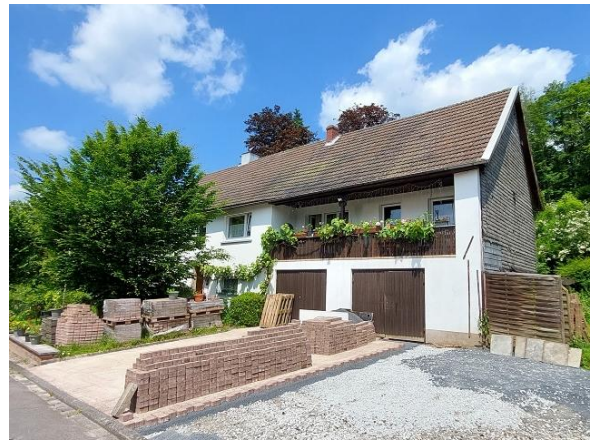
Abbildung 116: Erfolgte Umnutzung in der Straße Wiesenweg im Ortsteil Korb
