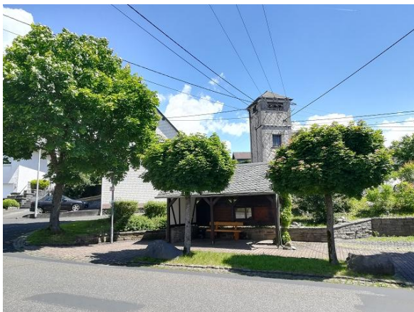
Abbildung 230: Bushaltestelle im Ortsteil Stangenrod auf der östlichen Seite der Unnauer Straße / K 61
