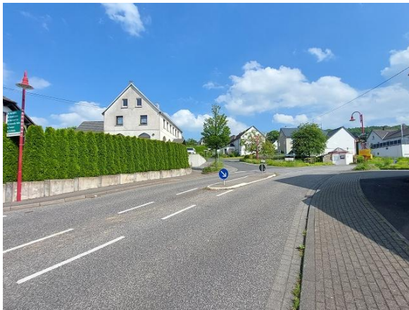
Abbildung 258: Überquerungshilfe in der Hauptstraße / L 293 im Ortsteil Unnau
