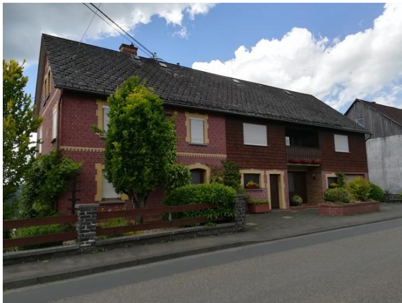
Abbildung 117: Erfolgte Umnutzung in der Unnauer Straße / K 61 im Ortsteil Stangenrod
