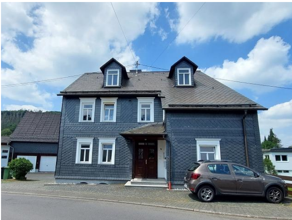
Abbildung 96: Fassadenverkleidung aus Naturschiefer im Ortsteil Korb
