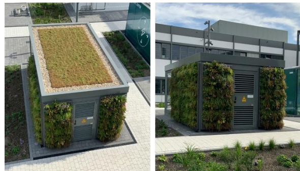
Abbildung 168: Beispiel eines begrünten Transformatorgebäudes Quelle: https://mobilane.com/app/uploads/2024/02/Mobilane-MobiPanelBetonbau-Fassadenbegrunung-1200x600-1.jpg
