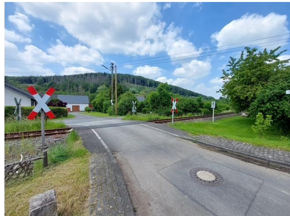
Abbildung 228: Bahnschienen in der Bahnhofstraße im Ortsteil Korb
