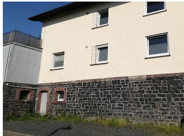
Abbildung 83: Sichtmauerwerk aus Naturstein im Ortsteil Unnau
