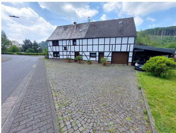
Abbildung 161: Natursteinpflasterhof in der Bahnhofstraße im Ortsteil Korb
