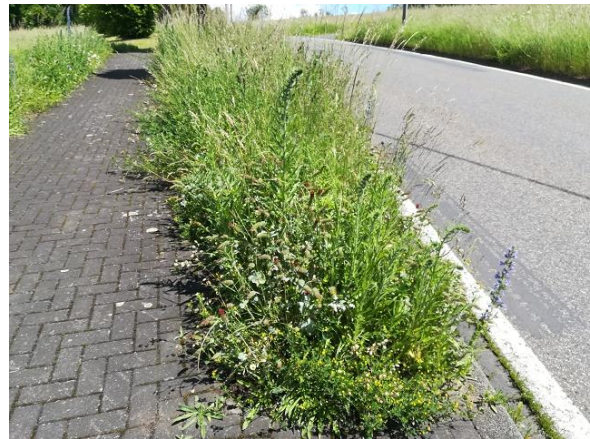
Abbildung 143: Straßenbeet zwischen der Fahrbahn und dem Fußweg am nördlichen Ortseingang im Ortsteil Stangenrod
