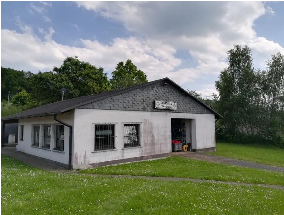
Abbildung 189: Vereinsheim am Sportplatz im Ortsteil Unnau
