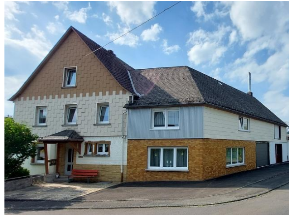
Abbildung 100: Fassadenverkleidung aus regionsuntypischem Material im Ortsteil Unnau
