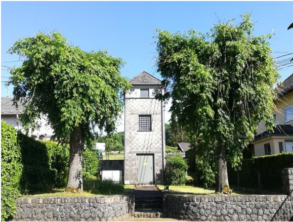
Abbildung 124: Grünfläche am Transformatorenturm im Ortsteil Unnau
