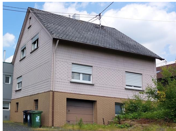
Abbildung 99: Fassadenverkleidung aus regionsuntypischem Material im Ortsteil Stangenrod
