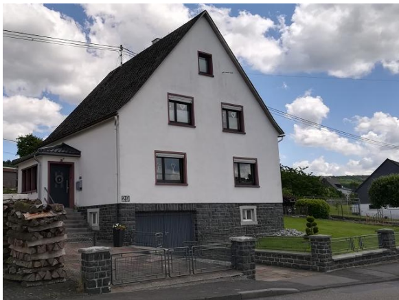
Abbildung 82: Sichtmauerwerk aus Naturstein im Ortsteil Stangenrod
