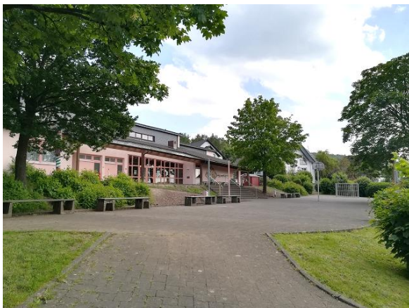
Abbildung 184: Grundschule im Ortsteil Unnau
