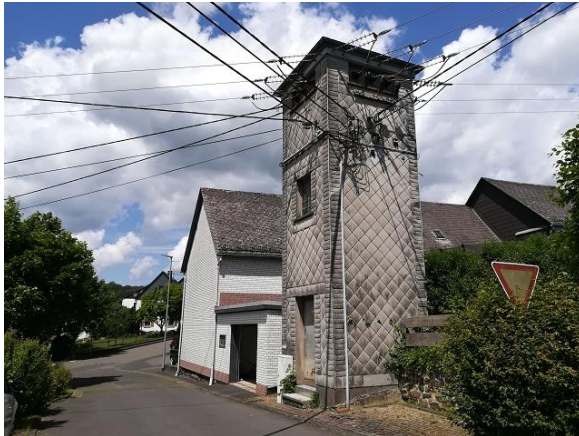
Abbildung 101: Negativ auf das Ortsbild wirkender Transformatorenturm in der Bornstraße im Ortsteil Stangenrod
