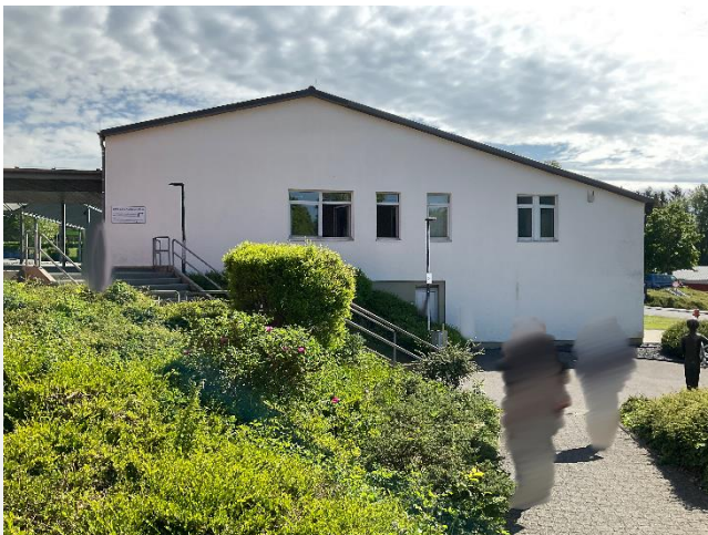
Abbildung 5: Gebäude 4 der Marie-Curie-Realschule plus. Ansicht der Westseite inkl. Tür zur Unterstation (Eigene Aufnahme, 05/2022)
