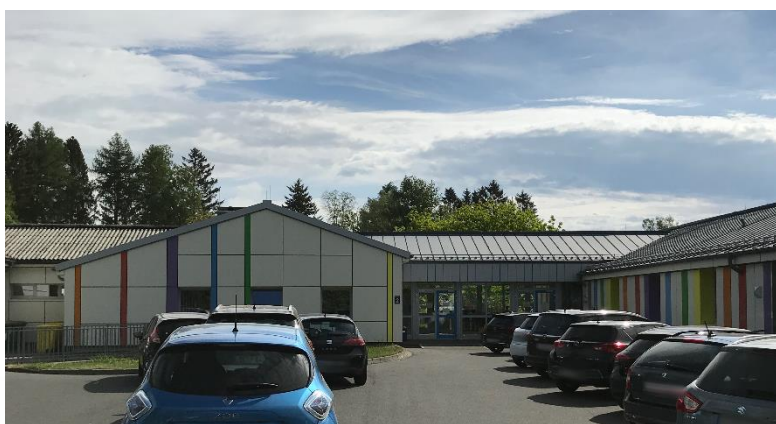
Abbildung 11: Haupteingang der Grundschule Wolfsteinschule (Eigene Aufnahme, 05/2022)
