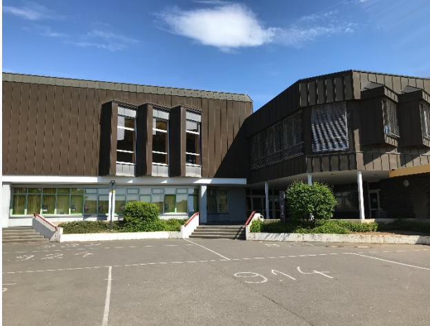
Abbildung 8: Zu sehen ist der Haupteingang des Gebäudes 13 (Forum) der Marie-Curie-Realschule Plus. Durch dieses Gebäude ist die Haupt-Heizzentrale der Liegenschaft zu erreichen (Eigene Aufnahme, 05/2022)
