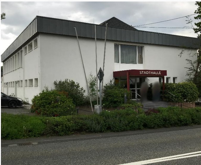
Abbildung 13: Die Stadthalle Bad Marienberg. Zu sehen ist der Haupteingang von der Kirburger Straße aus (Eigene Aufnahme, 05/2022)
